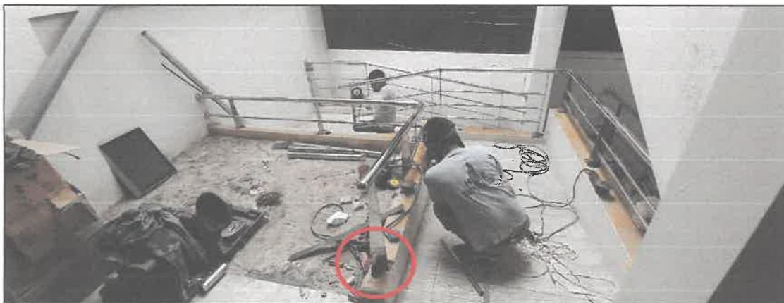
Se observa el picado que se realizó para el retiro de las barandas anteriores e instalación de las nuevas barandas de acero.
